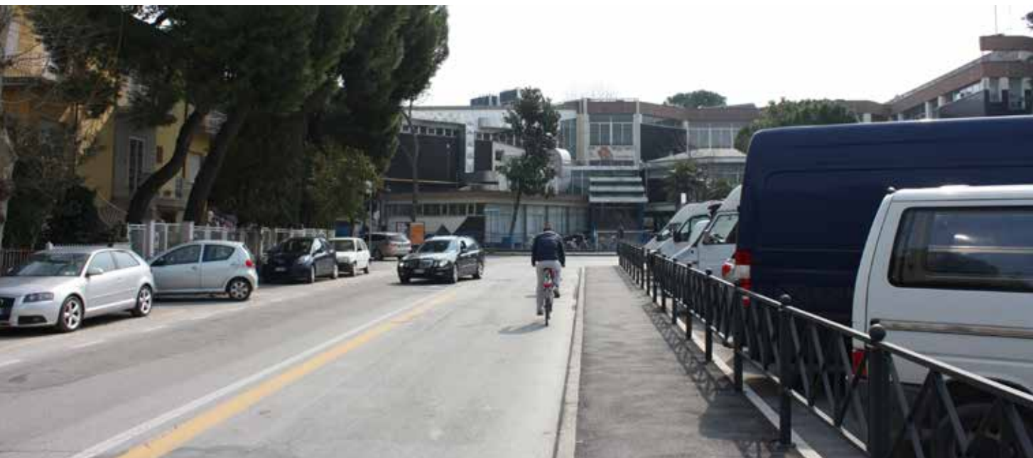
CARREGGIATA SU PIAZZALE GRAMSCI TRA VIA CORNELIA E VIA BRIGHENTI
