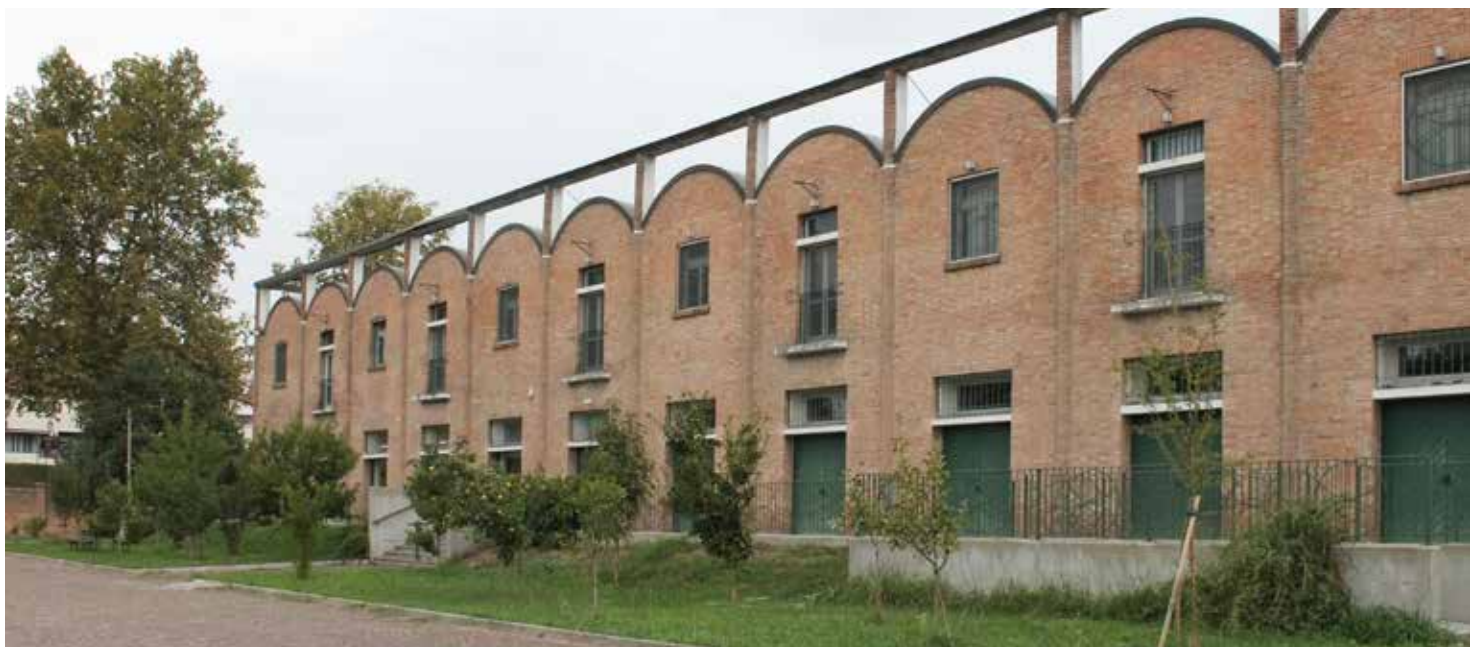
EX MAGAZZINI GENERALI 'EDIFICIO 'SAVONUZZI', ORA SEDE DI DIVERSE ASSOCIAZIONI
