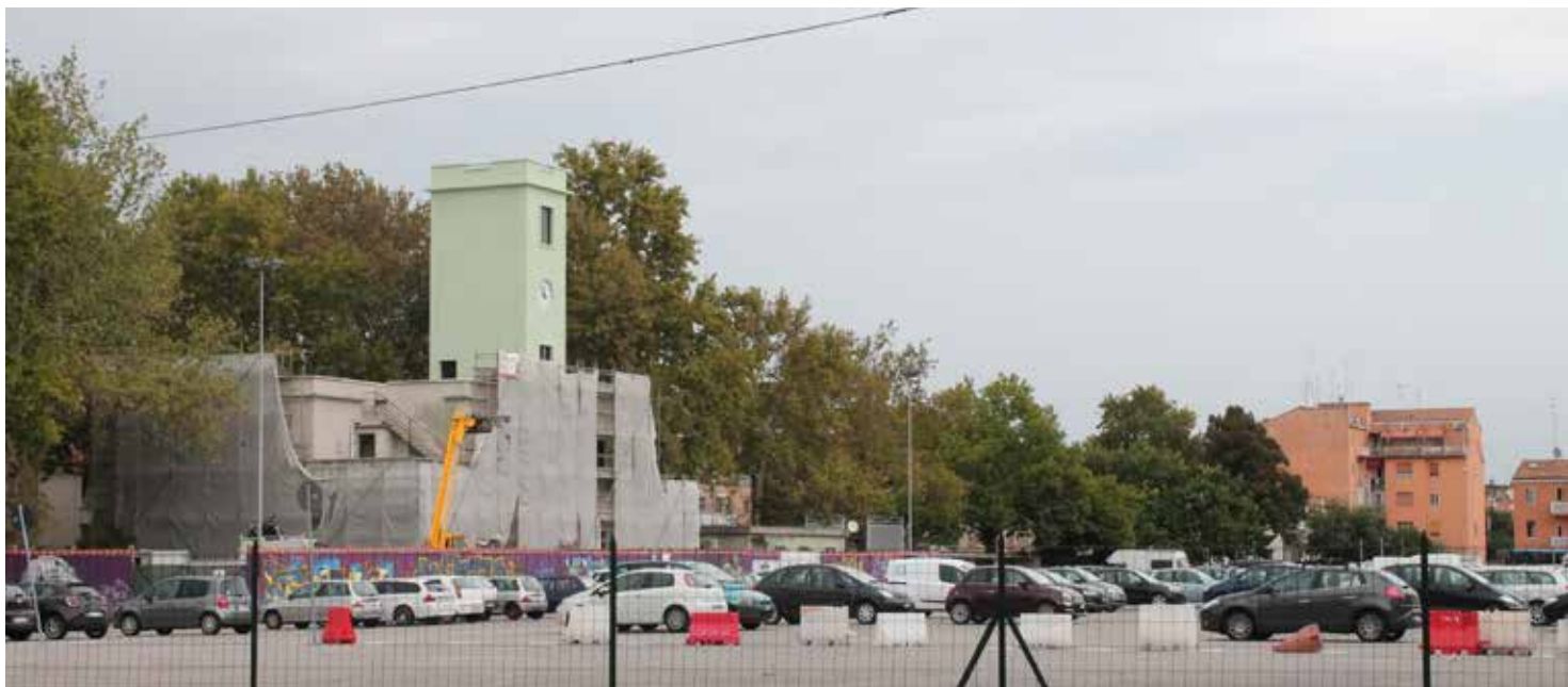
L'AREA DELL'EX MOF, ORA ADIBITA A PARCHEGGIO, E LA PALAZZINA EX MOF IN FASE DI RESTAUTO
