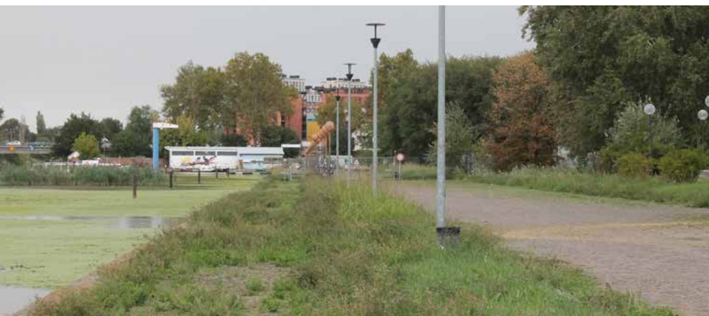
LA BANCHINA LUNGO IL CANALE DI BURANA
