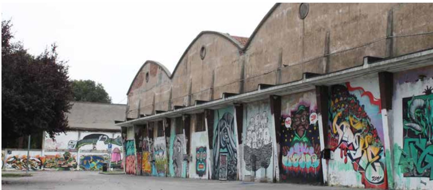
MAGAZZINI DISMESSI DI CUI SI PREVEDE LA DEMOLIZIONE (BANDO PERIFERIE)
