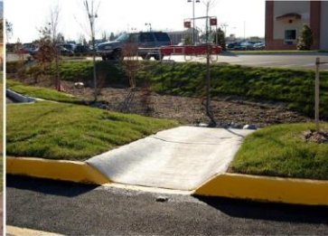
Cunetta per l'invio dell'acqua meteorica a un rain garden
