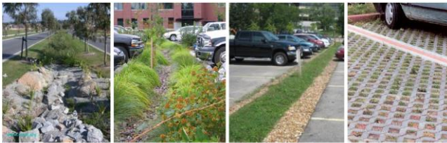
Trincee filtranti applicate a strade e parcheggi, pavimentazione drenante
