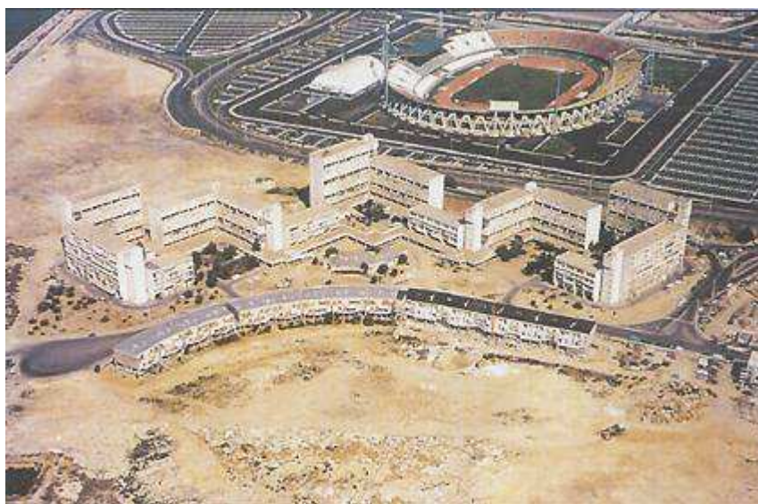
Figura 18.1. Visione aerea di Sant'Elia, Borgo Nuovo.
