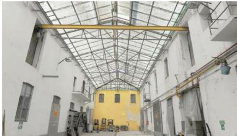
L'ampio spazio del Deposito Franco ex Salso di Porto Maurizio
