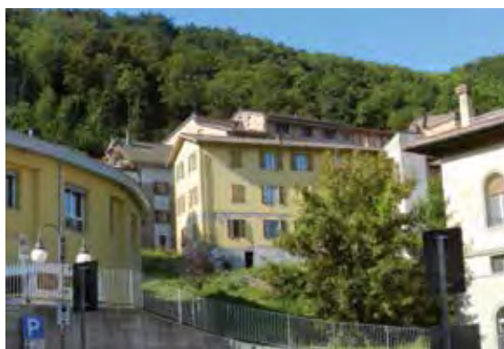
Ex casa protetta Stato attuale con edificio da abbattere
