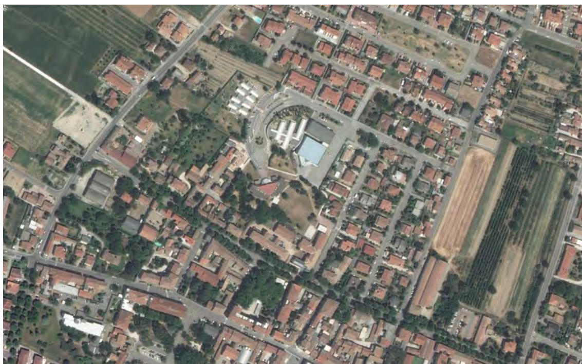
Foto aerea con individuazione dell'ambito di intervento
