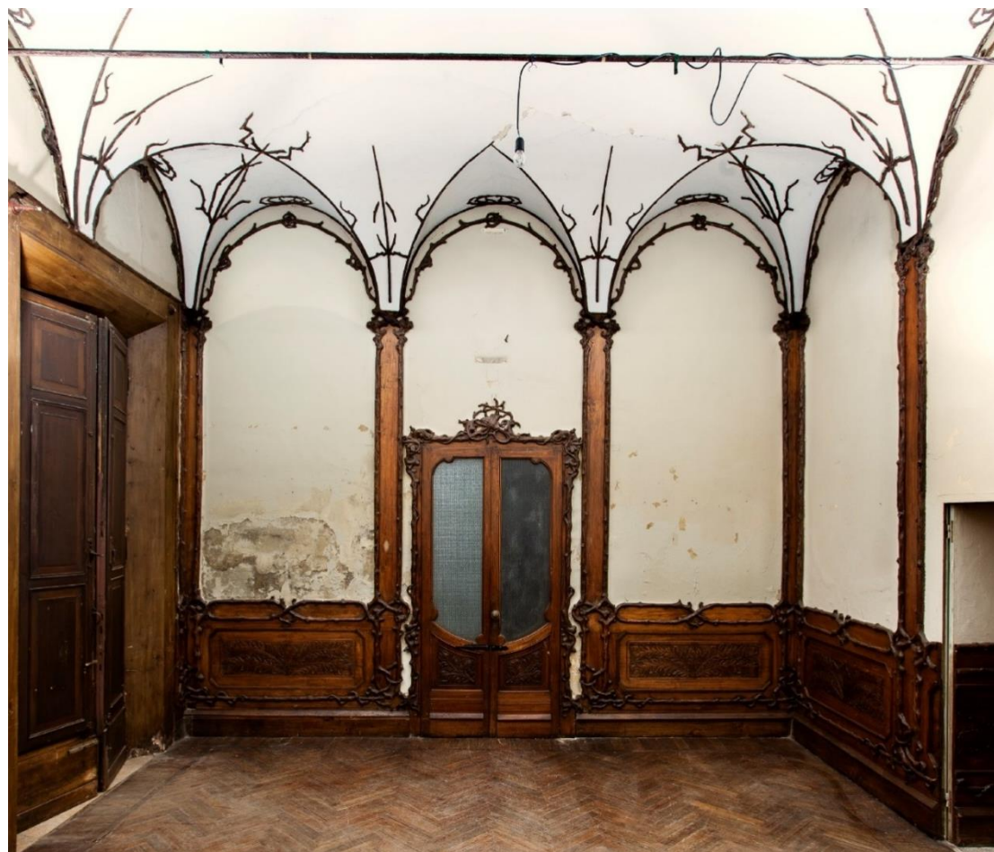
Foto interna – Piano terra
