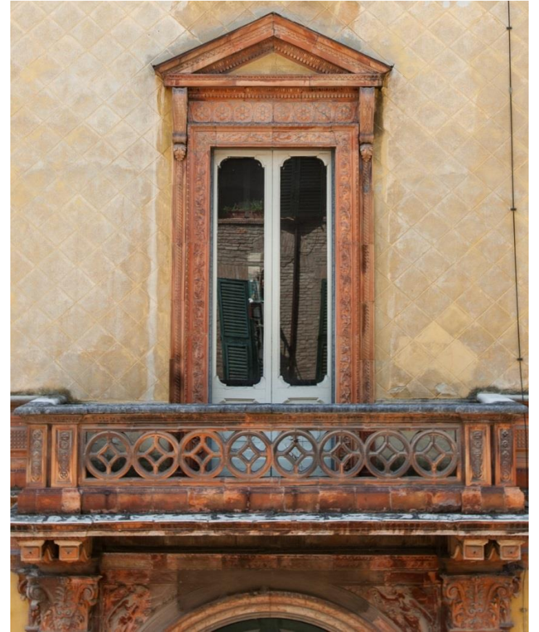
Foto esterna – Particolare portafinestra P1
