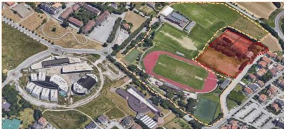
Area di recupero e riqualificazione del Centro tennis Leoncavallo – Campus sportivo
