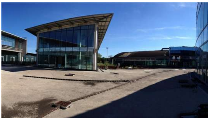
Foto 2: VGS mai utilizzato ed in stato di abbandono
