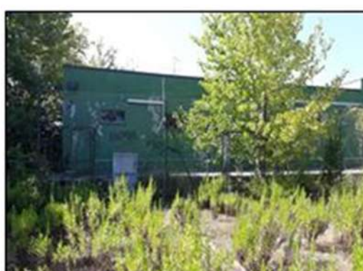
Fot 4 campo principale e club house stato attuale
