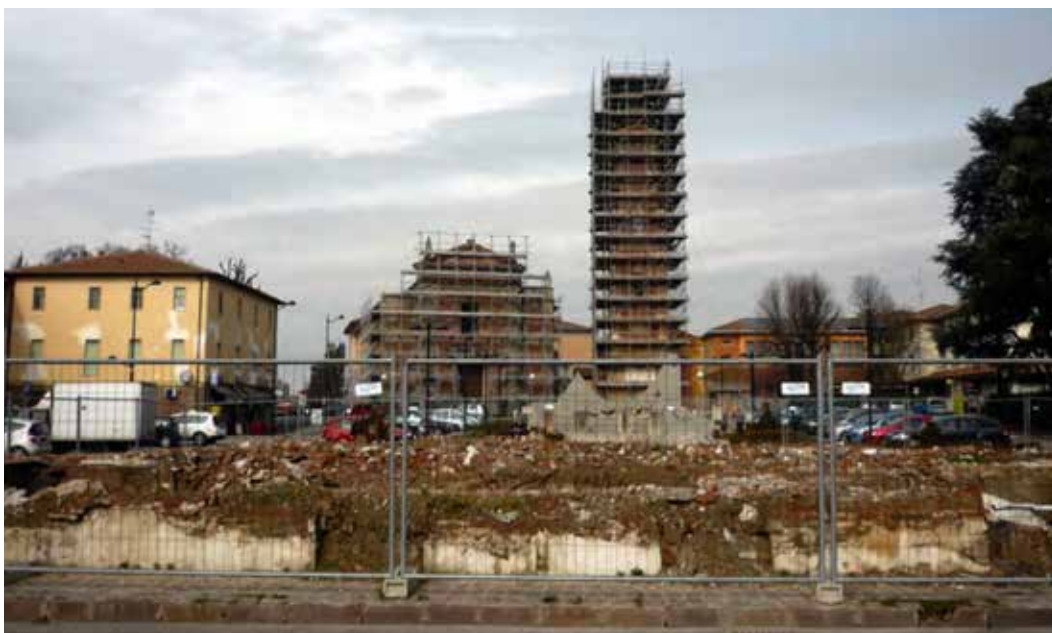
Le macerie del Municipio dopo la demolizione, sullo sfondo Piazza Marconi e la Chiesa
