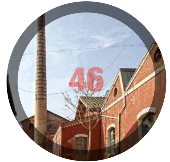
In copertina: STAVECO, foto di Marco Pintacorona
