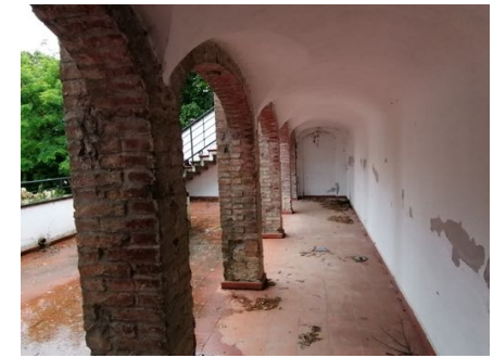
La terrazza porticata
