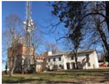
L'ex ristorante e l'area tecnologica adiacente
