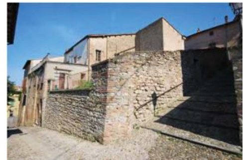
Il muro esterno su Via Fossato
