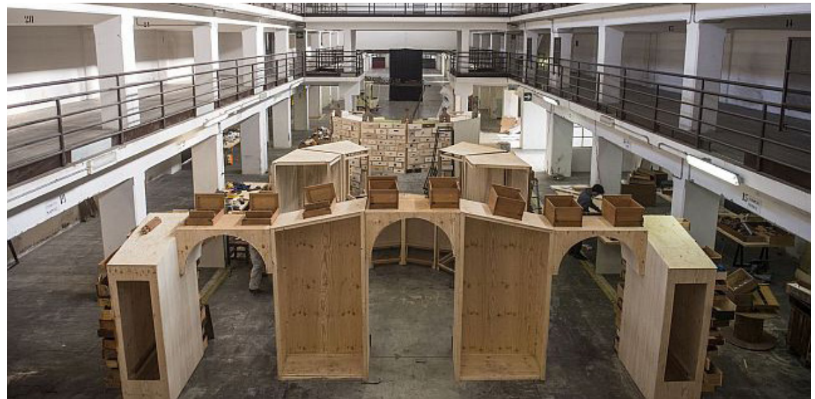
“CAPANNONE 3” - PREPARAZIONE AL VECCHIONE, CANTIERE METICCI, DICEMBRE 2019
