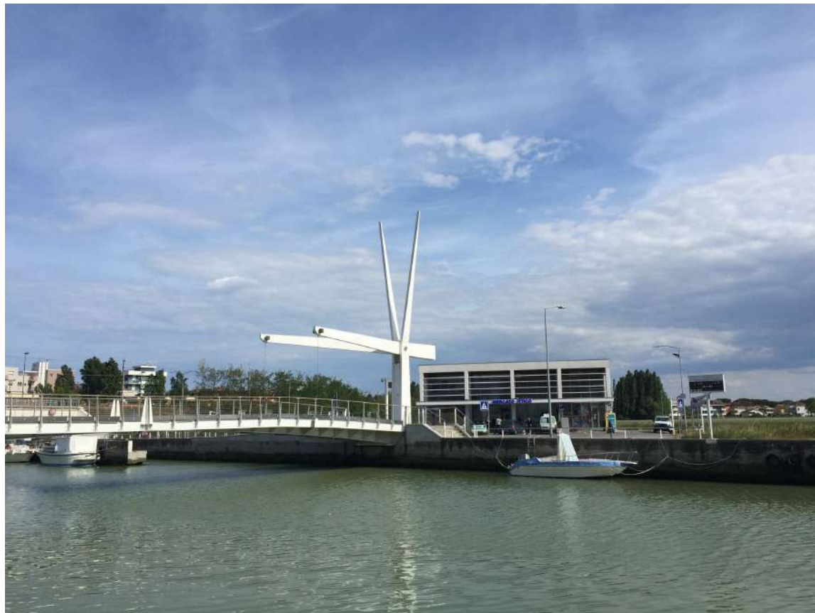
Il nuovo mercato ittico ed il ponte ciclo-pedonale mobile
