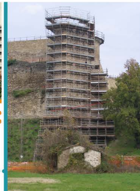
2° STRALCIO - Restauro e consolidamento delle cortine murarie di sud - est e della torre circolare est
