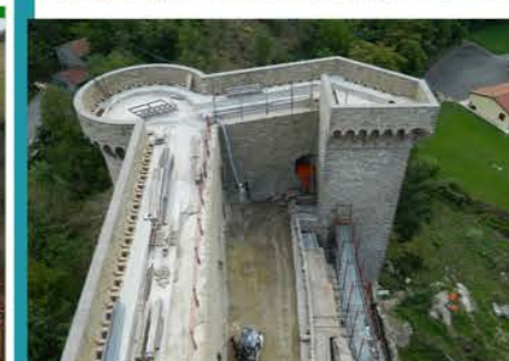
3° STRALCIO 1° LOTTO - Restauro e consolidamento della torre poligonale sud e della sommità delle cortine murarie
