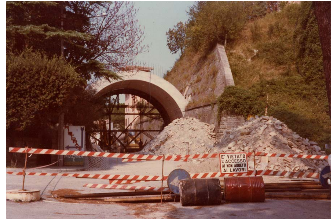
Foto n. 2 – Vista della prima fase di edificazione del tunnel in cemento armato
