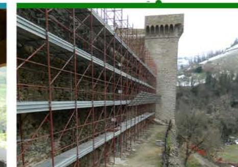
3° STRALCIO 2° LOTTO - Ripristino delle scale e delle strutture di collegamento tra 1° e 2° terrazzamento
