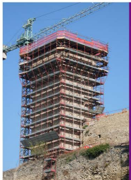
1° STRALCIO - Restauro e consolidamento esterno ed interno della torre maschio
