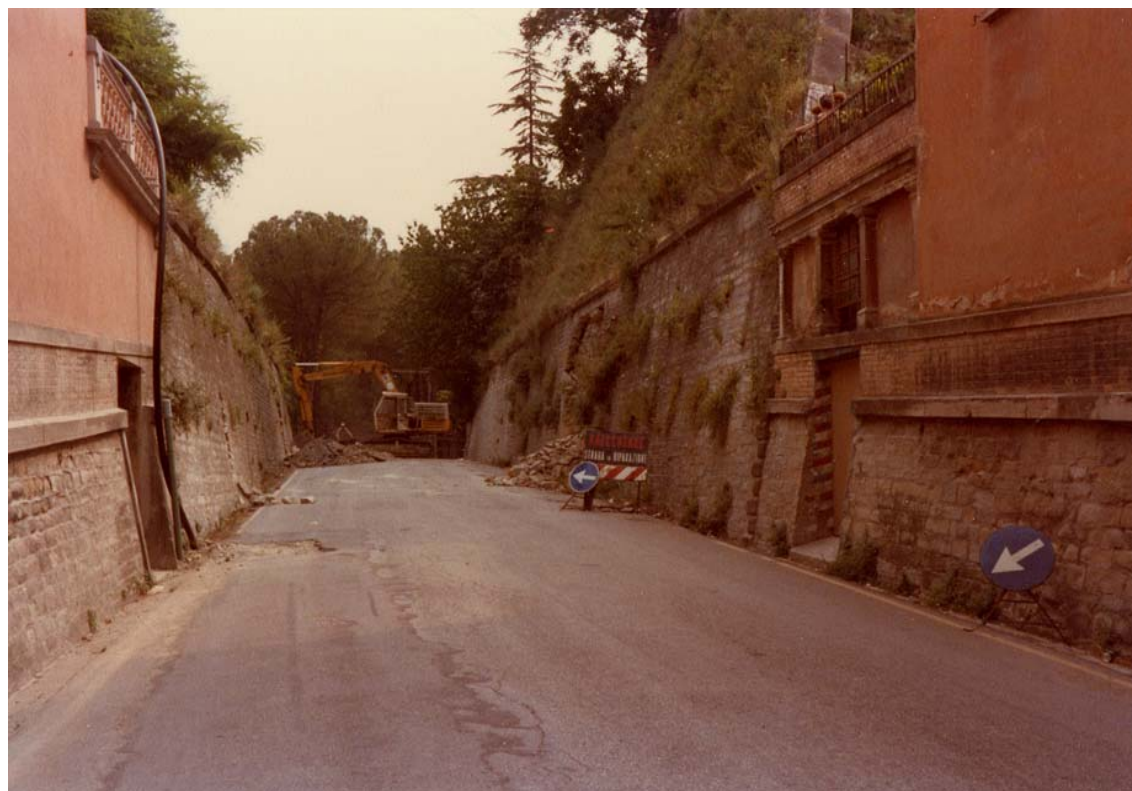
Foto n. 1 – Il tratto della Strada Statale 67 interessato dai primi lavori di costruzione del tunnel
