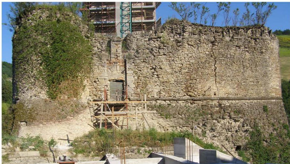
5° STRALCIO Restauro e consolidamento delle cortine murarie di Nord - Ovest
