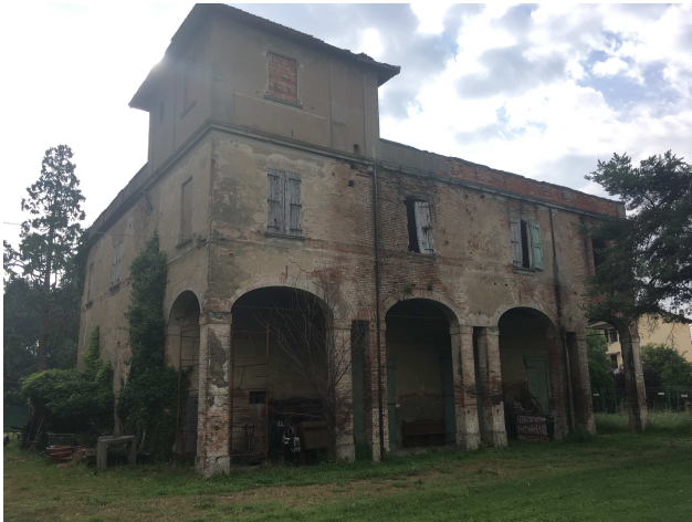
Foto del fabbricato "Barchessa destra" in evidente stato di precarietà statica (inagibile)
