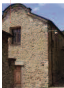
SI Muratura sottoposta ad intervento di conservazione
