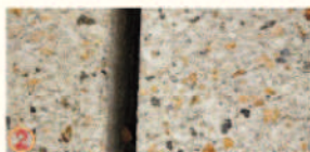
2 DETTAGLIO PAVIMENTAZIONE IN CEMENTO CON INERTI COLORATI
