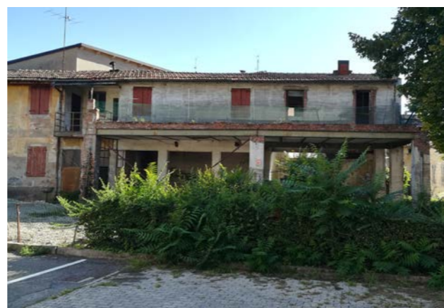
Area Benetti Edifici degradati
