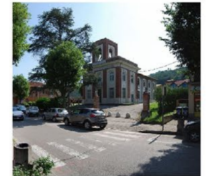
Ex Casa del Fascio
