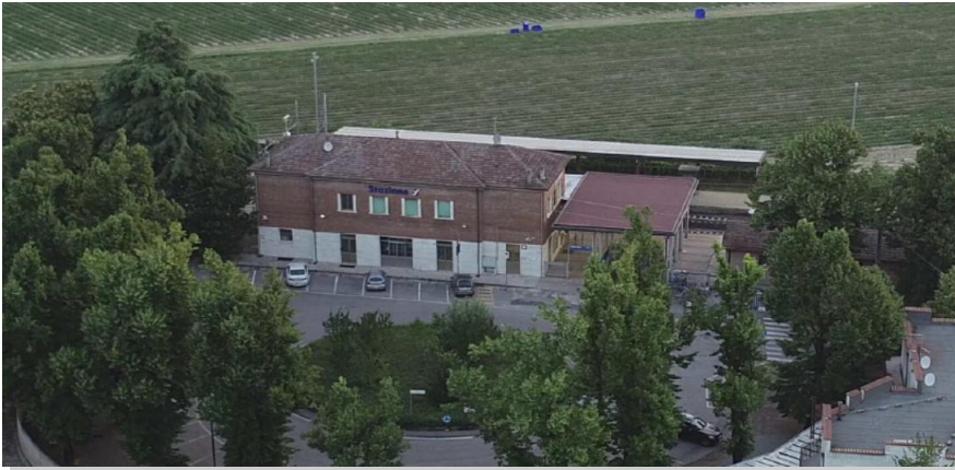
Vista aerea della Stazione Ferroviaria Forlimpopoli Bertinoro
