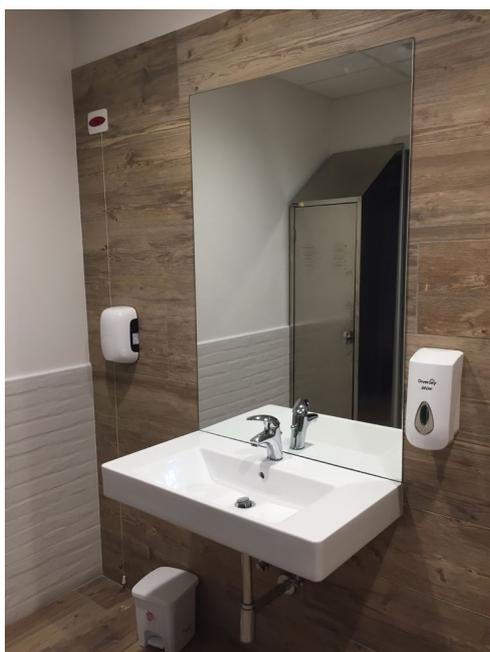
L'uso dei miscelatori con il comando a leva è ideale, ma non modelli di tipo sanitario a leva lunga, bensì a leva classica, oppure a fotocellula. È consigliabile l'uso di termostati per il controllo automatico della temperatura dell'acqua, così da evitare possibili scottature agli utenti non vedenti o un po' distratti.
