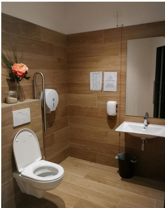
+ Bagno con sanitari di tipo sospeso. Si noti come sono stati inseriti sanitari "normali", che con i dovuti accorgimenti, possono essere utilizzati per un bagno riservato.
