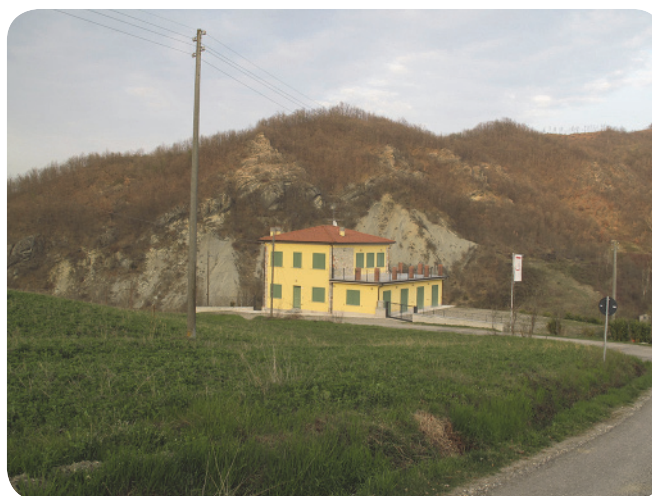
14 . La residenza di colore giallo è stata costruita a ridosso della strada panoramica.
