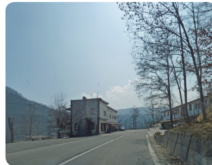
2 . Percorrendo la strada provinciale 412, che nella parte occidentale perimetra l'area tutelata, spicca un edificio a sinistra, a ridosso del lago Trebecco.
