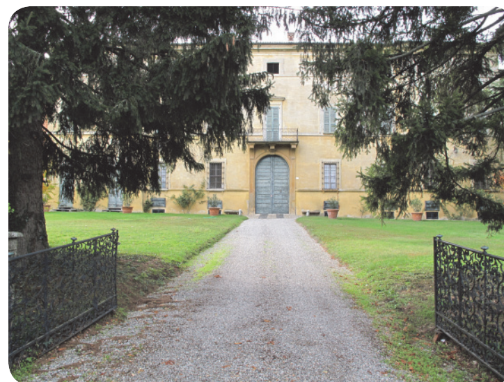
2 . L'accesso principale dialoga con la vicina chiesa parrocchiale e l'adiacente villa Peirano.
