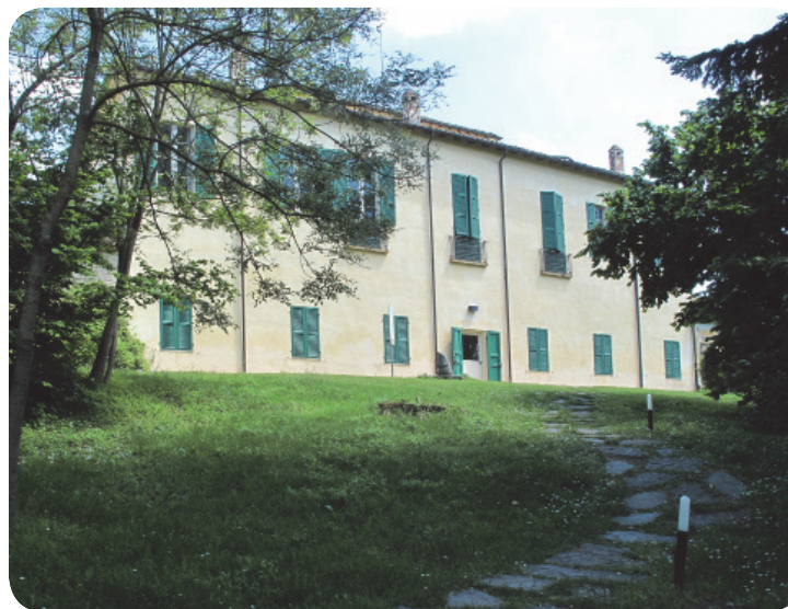
1 . Casino dei Boschi. Il corpo centrale del complesso, ristrutturato.
