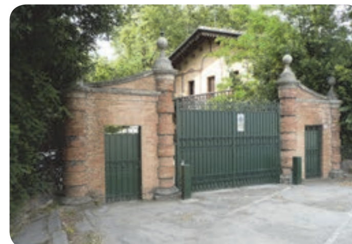
4 . Il secondo accesso laterale che si affaccia sulla via Emilia; si intravede un altro annesso.
