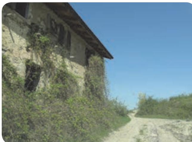
2 . L'edilizia rurale di Carfico, in stato di significativo degrado e di abbandono.
