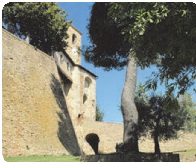
1 . Accesso alla zona murata.
