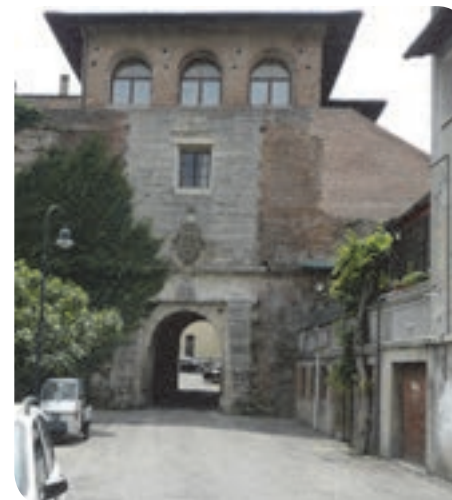
8 . La porta (e il castello) verso Forlì, con l'edificato sviluppatosi a ridosso della fortezza.
