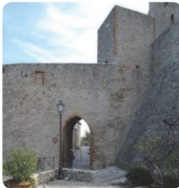
1 . Una porta di accesso alla zona murata, di un'architettura semplice.
