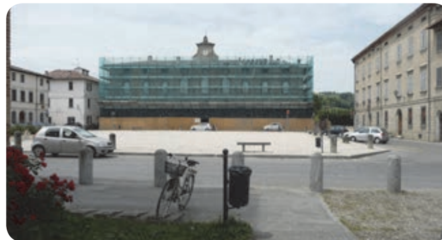
12 . La piazza d'armi, oggi Piazza Fulceri; Palazzo dei Commissari, nascosto dall'impalcatura, è in ristrutturazione.
