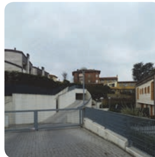
2 . Nuova edificazione a lato di via Croara al bivio con via di San Ruffillo.
