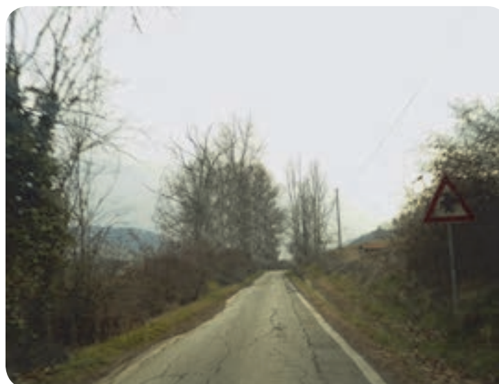
7 . La strada (in alcuni tratti non ben mantenuta) che percorre la parte pianeggiante fiancheggia il corso del fiume Idice, e ai due lati si vedono le fasce collinari.
