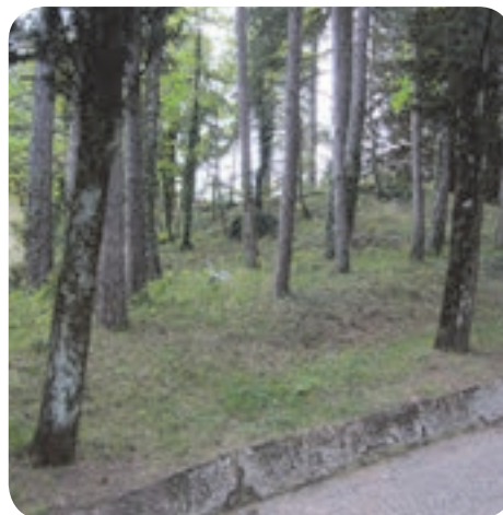
3 . La zona erbosa e il separatore dal manto stradale non ben curati
