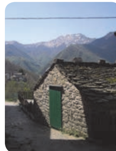
2 . Tipica costruzione in sasso con tetto in arenaria.
