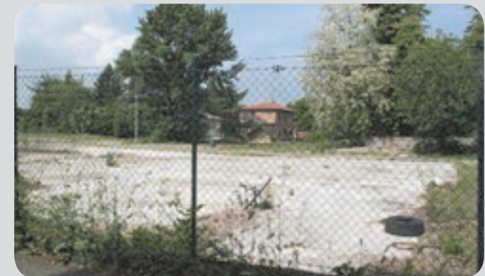
7 . ... e da un ampio spazio cementato e in stato di abbandono.
