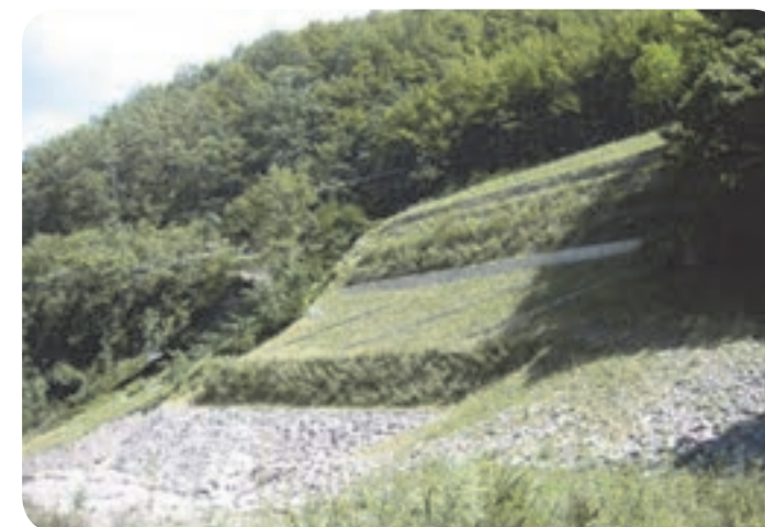
5 . L'area di frana due anni dopo l'intervento di sistemazione (2002)
