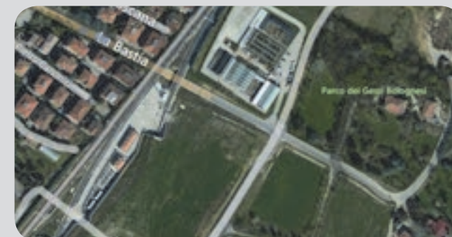
8 . Il recente sottopassaggio dell'alta velocità ferroviaria costruito a ridosso dell'esistente ferrovia Bologna-Firenze.
