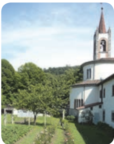
14 . L’abside della chiesa del Convento sul Savio
