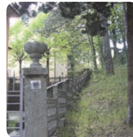
5 . Il perimetro dell'area confina a sud-est con edifici privati e ne è separata da una recinzione in cemento.
