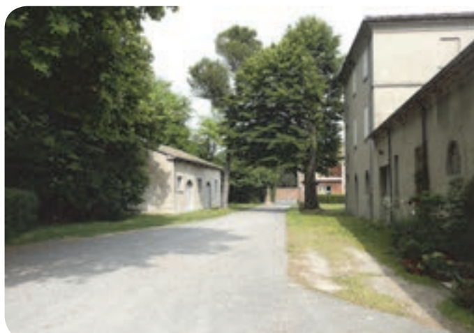
3 . L'accesso che conduce alla villa, visto dall'interno dell'area; a dx e a sx gli annessi.
