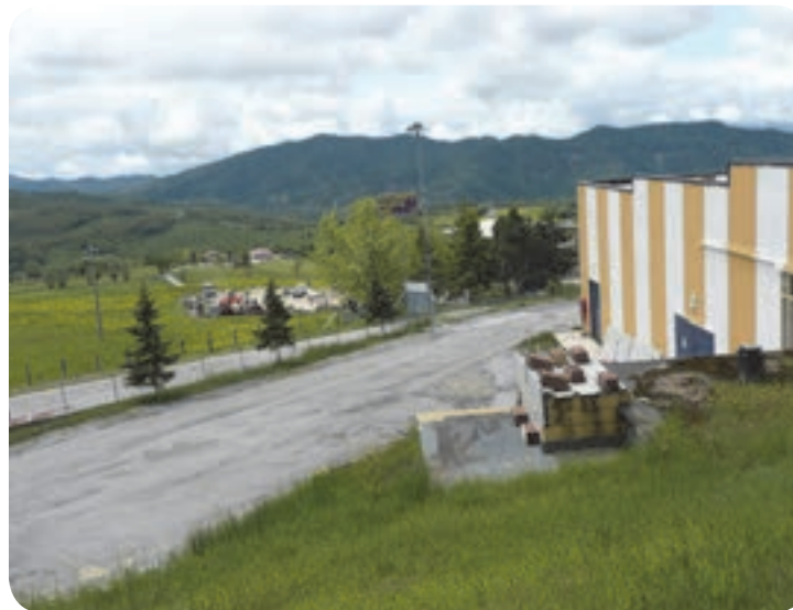
3 . Arrivando in località le Balze si notano alcuni capannoni incongrui; lo sfondo è sempre caratterizzato dalla presenza dei verdeggianti rilievi appenninici.
