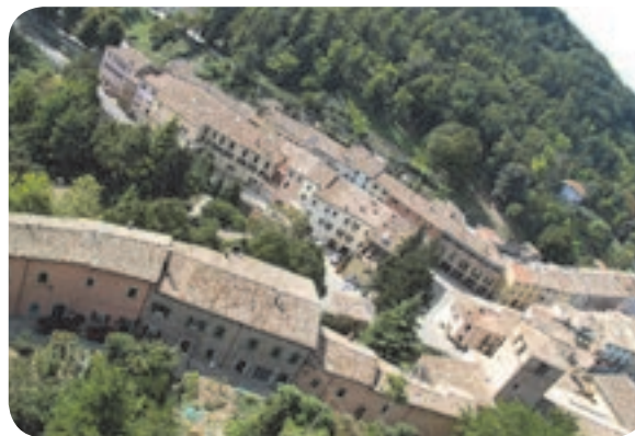
2 . Il borgo, che segue longitudinalmente l'andamento morfologico del colle.
