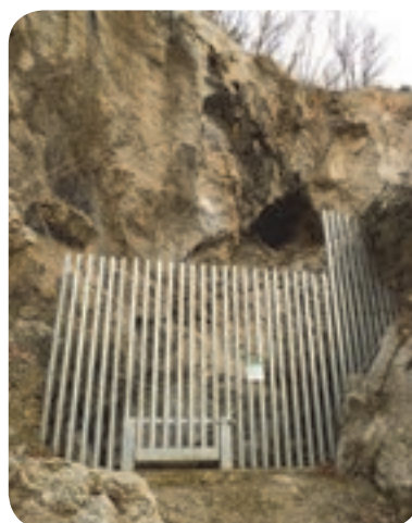
3 . Apertura nella roccia per accedere alla grotta.
