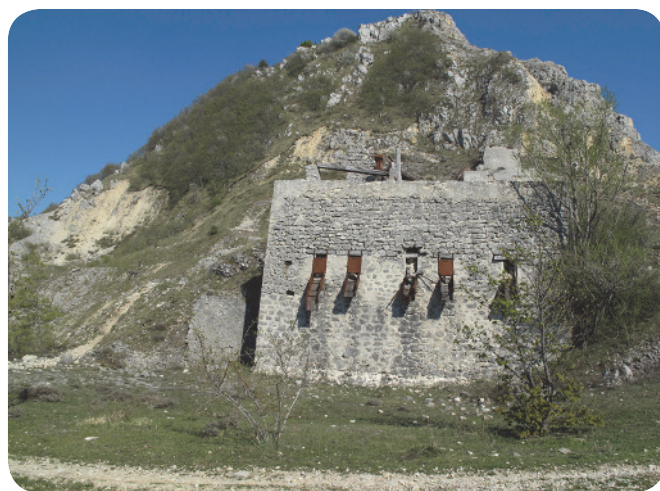
2 . Resti di strutture probabilmente utilizzate dalle precedenti attività estrattive.
