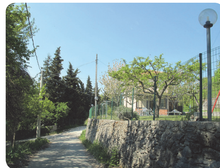
4 . Ulteriore enfasi sul segno paesaggistico rappresentato dai muretti di contenimento.
