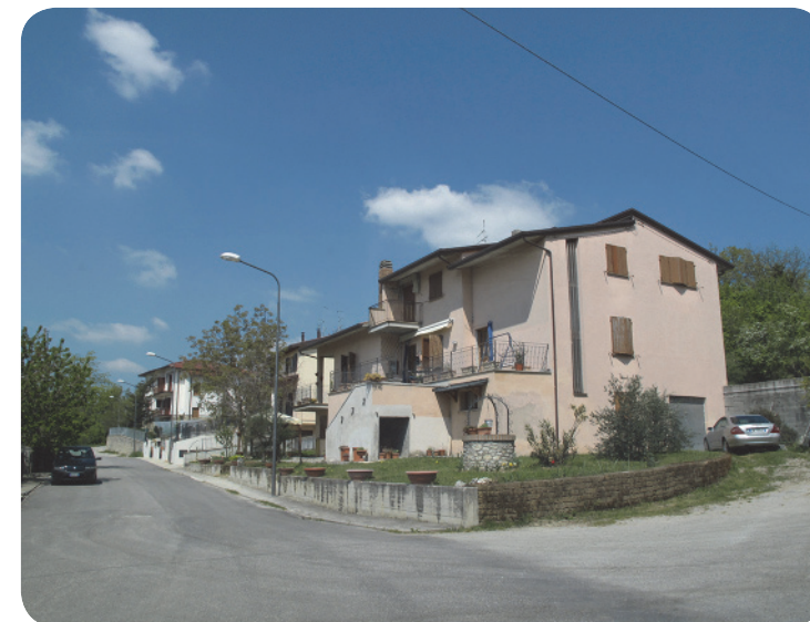
2 . I materiali utilizzati nell'edilizia recente (si notino i muretti) e il linguaggio architettonico connotativo dei fabbricati non si inseriscono armoniosamente nel paesaggio di riferimento.
