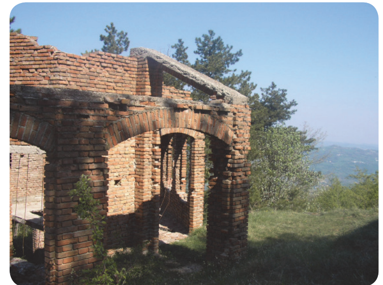
7 - Nel bosco, verso la cima di monte Perticara, si trovano i ruderi della chiesa costruita negli anni '50 del XX secolo.
