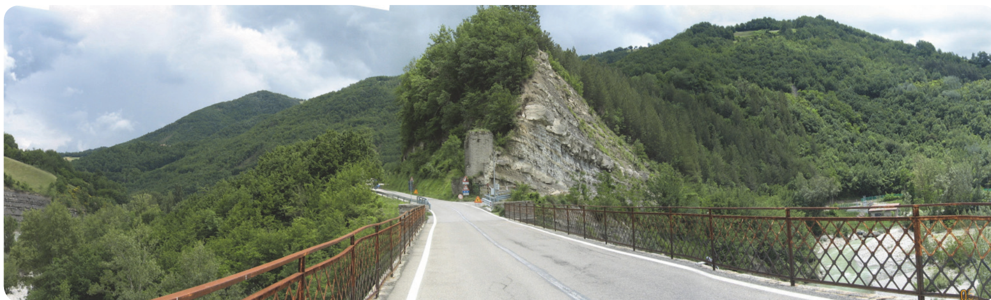
11. Veduta dell'area dal ponte di Vetto verso est.
