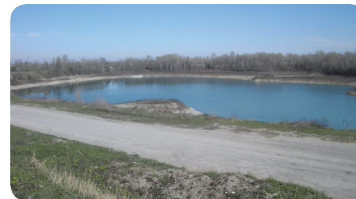
2 . Casse d'espansione del Secchia, vista dall'argine nei pressi del Podere Isola.
