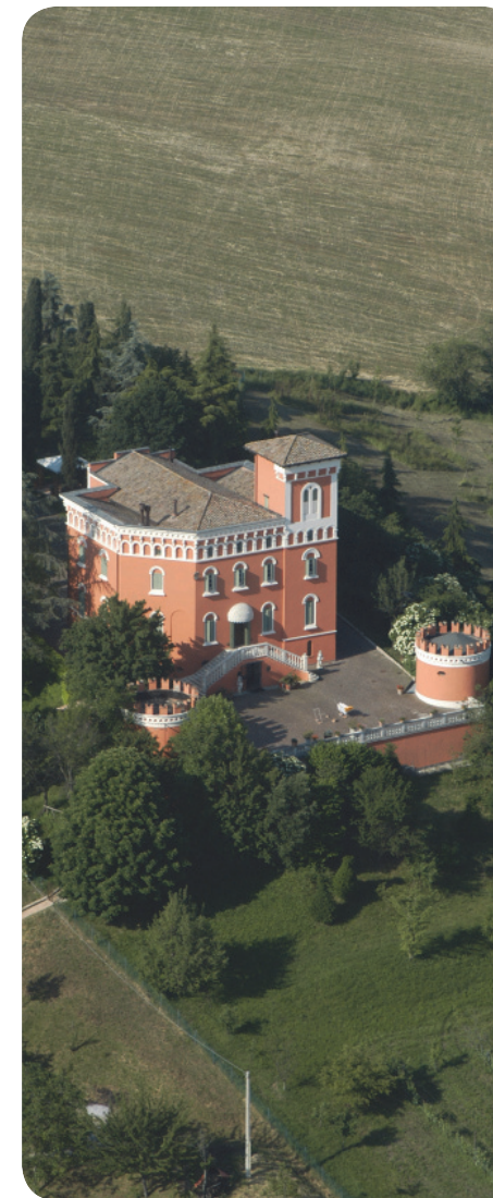
7 . Pantaro di Sopra, vista dal lato occidentale.
