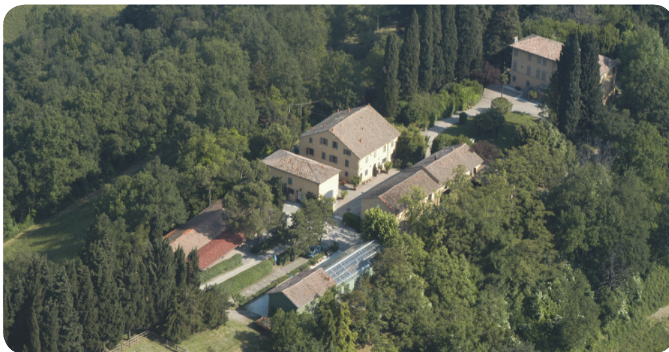
10 . Complesso di villa Manodori visto da sud-est.
