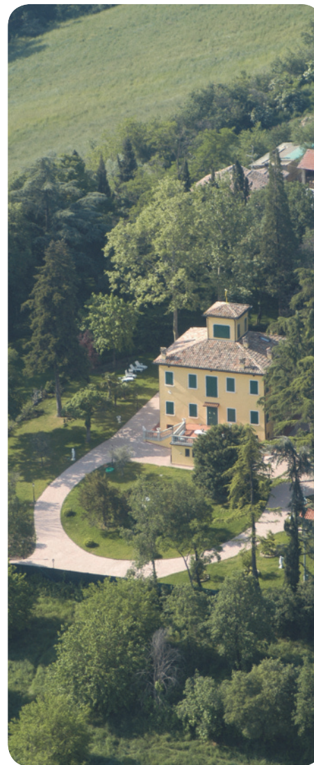
6 . Pantaro di Sopra, vista dal lato occidentale.
