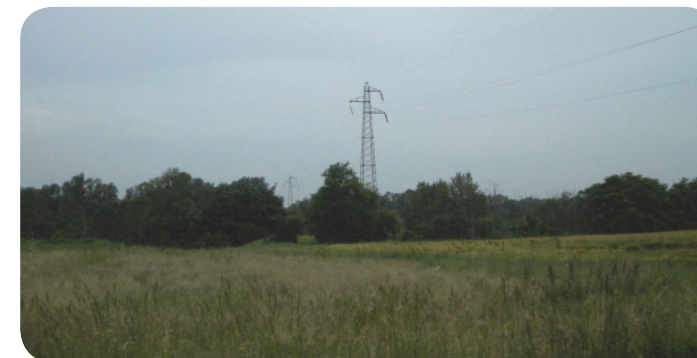
2 . Formazioni boschive e linea elettrica alta tensione nella zona sud-occidentale.
