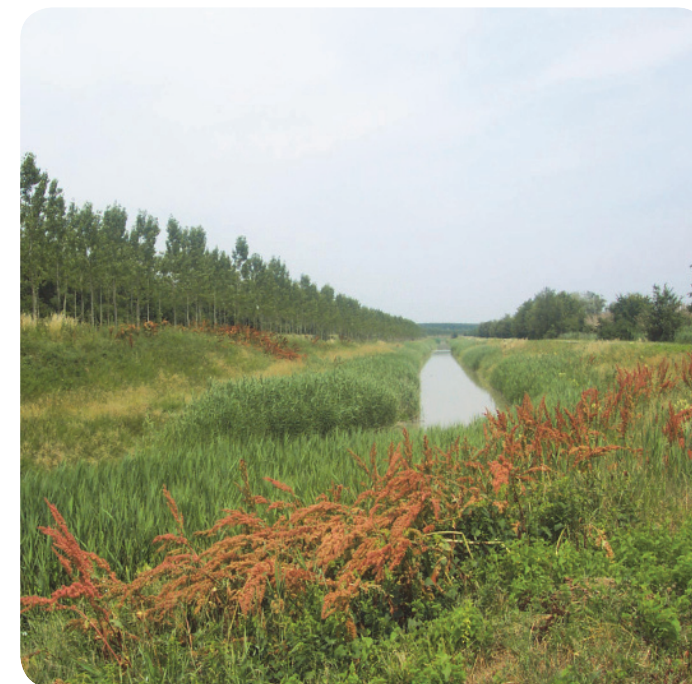
2 . Collettore Acque Basse Reggiane, vista verso nord.
