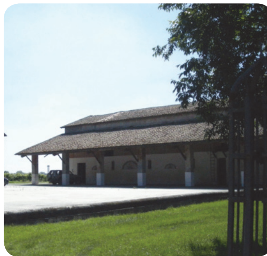
12 . Insediamento agricolo "La Gatta", aia interna.
