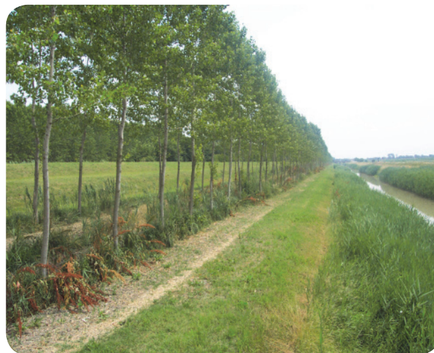
7 . Collettore Acque Basse Reggiane, vista verso sud-est.
