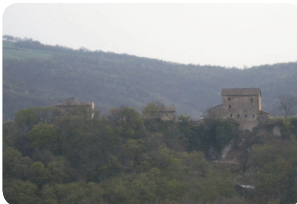
5 . Castello di Borzano, vista da nord.
