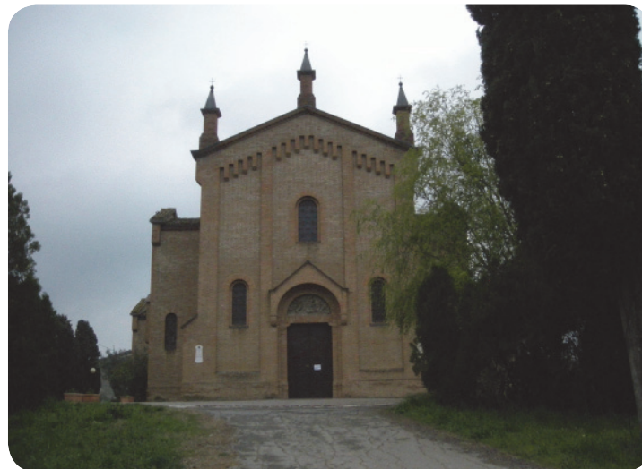
5 . Chiesa di Montericco.
