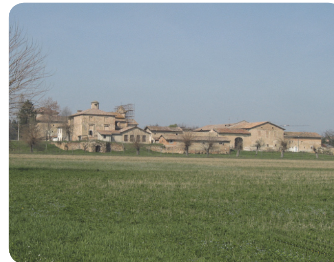
6 . Annessi rurali del complesso ducale di Rivalta.
