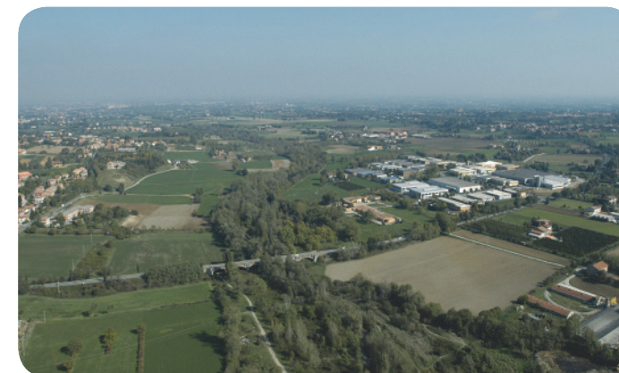
2 . Viste d'insieme da sud del ponte sul Crostolo a Puianello verso nord.
