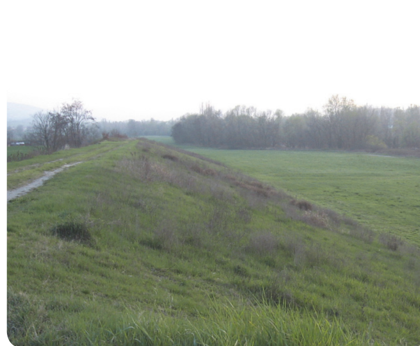
15 . Visuale dall'argine del Crostolo verso sud-ovest.
