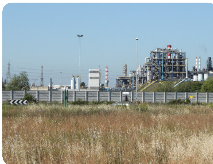
10 . Un'immagine di "dettaglio" della vasta zona industriale sviluppatasi a ridosso delle pialasse ravennate e della pineta di San Vitale.
