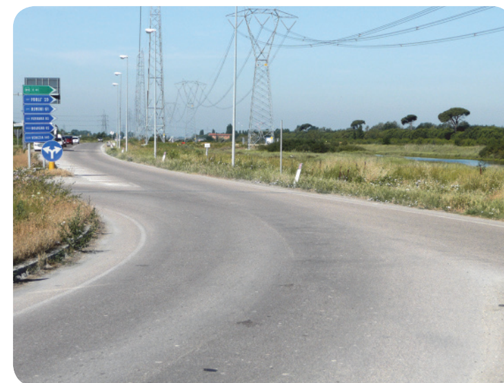
11 . Il raccordo che connette la zona industriale con la Strada Statale 309 Romea; sulla destra si vedono sia la Pialassa Baiona sia la pineta di San Vitale.
