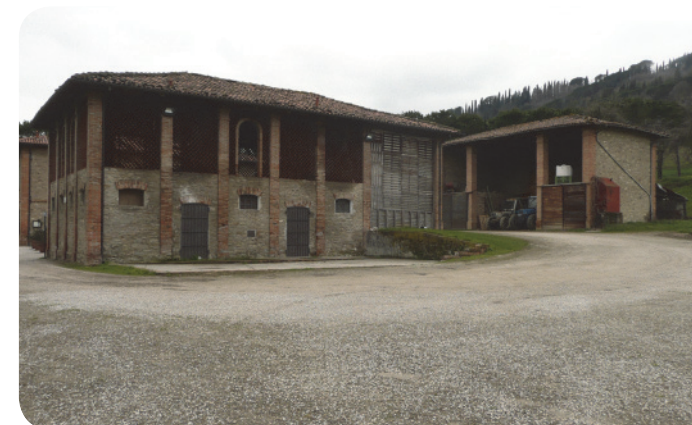
4. QRustici del podere Mengolta utilizzati prevalentemente per il rimessaggio degli attrezzi agricoli, visti dal parcheggio connesso alla locanda.
