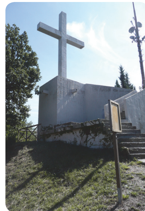
5 . La struttura in cemento che ha sostituito l'originaria croce.
