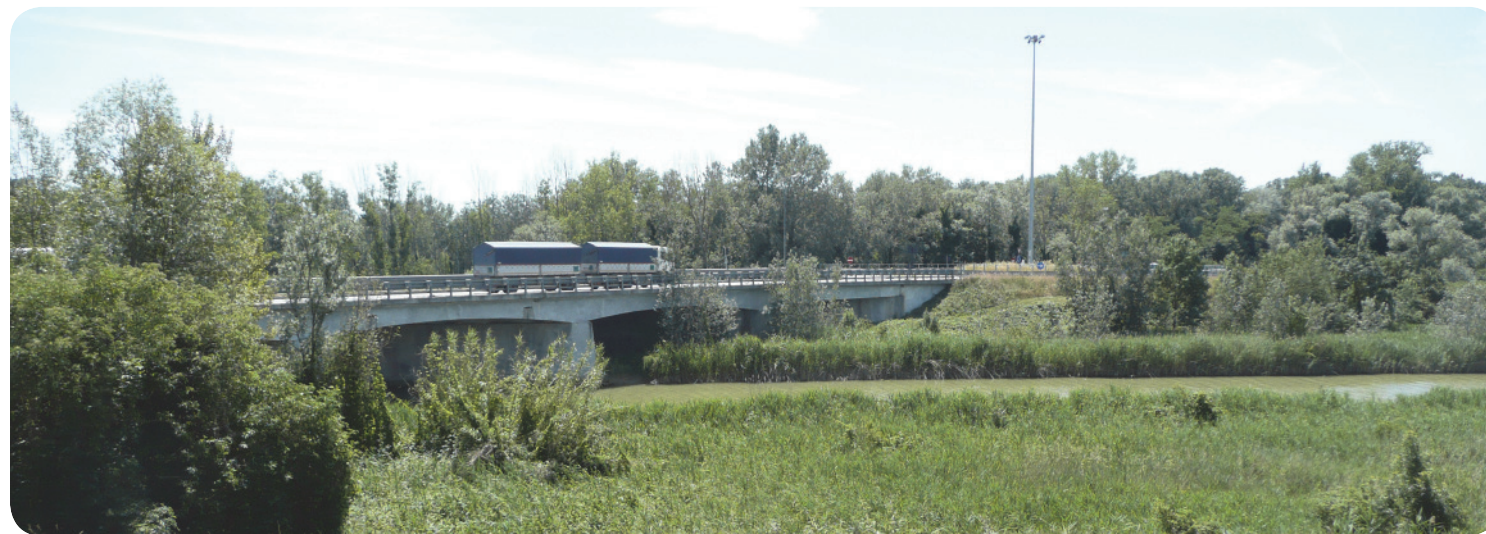
1 . Attraversato il Lamone, dirigendosi verso sud, la Romea divide la pineta di San Vitale (la massa boscata che domina l'immagine, a sx della strada) da Ponte Alberete (scorcio a dx).
