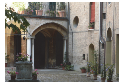
3 . Dettaglio dell'ingresso dal portico principale.
