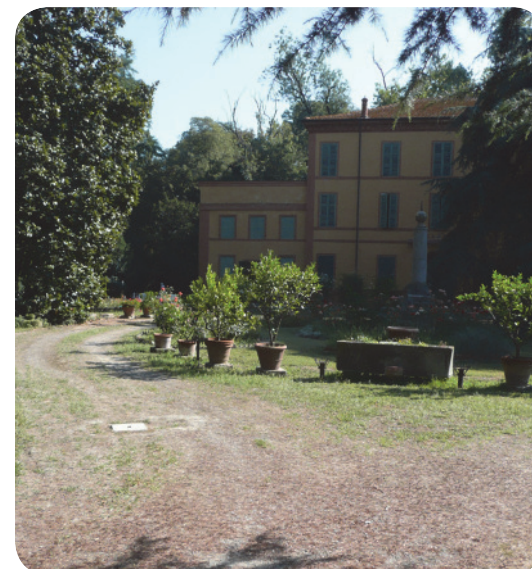
3 . Vista della villa presente all'interno del parco.
