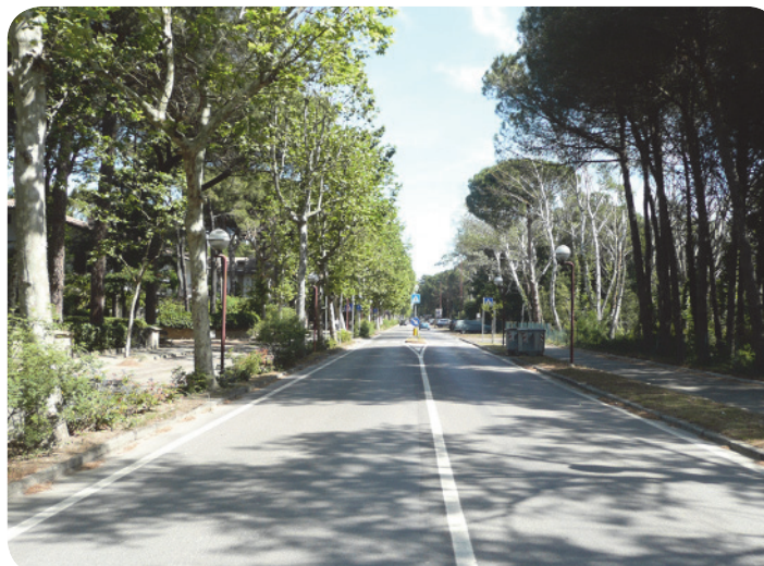
2 . Viale Italia a Marina Romea: a sx, oltre il controviale, si intravede l'urbanizzato che si è sviluppato lungo la strada, arrivando fino a ridosso della pialassa Baiona; a dx la pineta.
