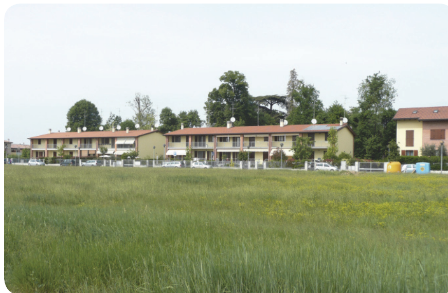
1 . Lottizzazione , costruita in diretta continuità con il perimetro del parco Gamba-Ghiselli.
