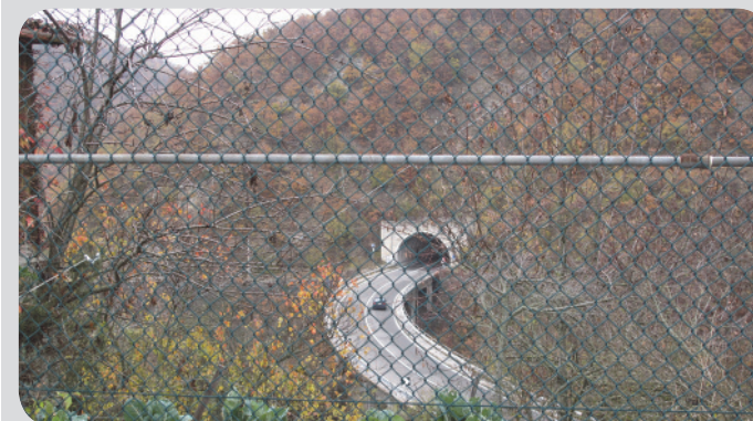
5. strada statale 45 - galleria verso Bobbio.
