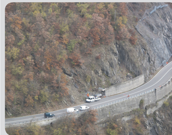
6. interventi di messa in sicurezza in un tratto della SS45 interessato dalla caduta di massi.
