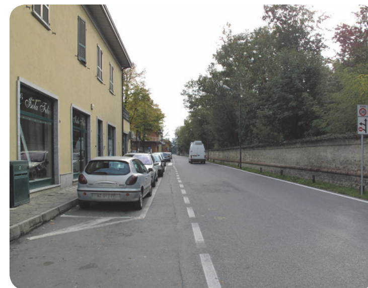
5 - Il muro di cinta su via Roma.
