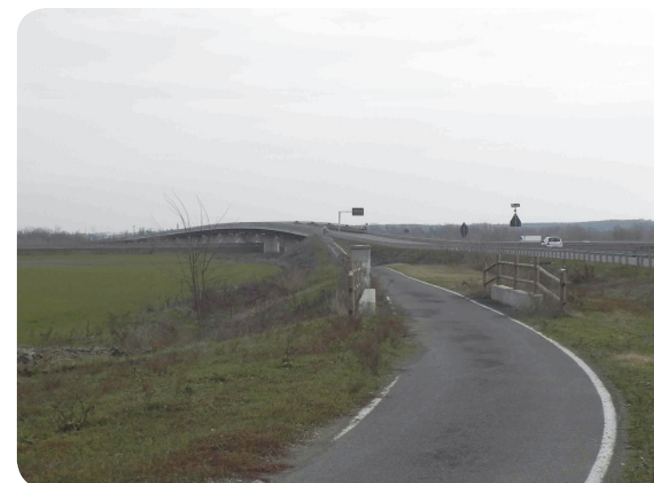
4. Il nuovo ponte Collecchio-Medesano sul fiume Taro, attraversa l'area tutelata circa a metà della sua lunghezza. Il ponte è dotato di pista ciclabile.
