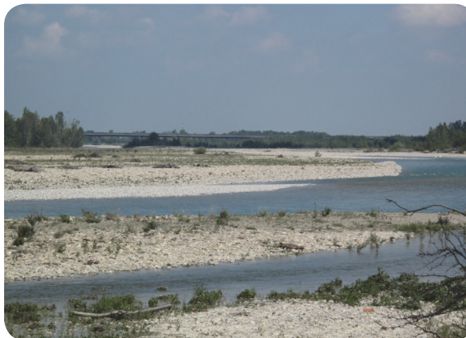
3 . Il fiume all'altezza di Pontescodogna; sullo sfondo il ponte Collecchio-Medesano.
