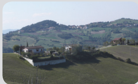
14 . Edilizia residenziale . muro di contenimento incongruo.
