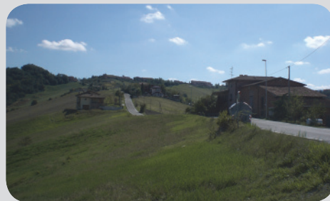
15 . Edilizia residenziale . interventi diffusi lungo la strada di crinale che conduce a Rocca Santa Maria.
