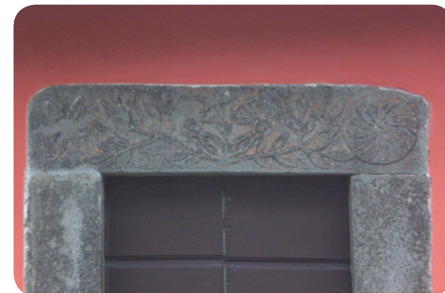
2. Casella . particolare dell’architrave
