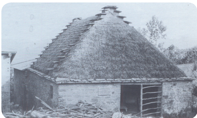
7. Roncacci . capanna celtica dopo il restauro del 1985.
