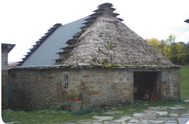
6. Roncacci . come si può notare, la copertura in paglia è stata parzialmente sostituita da una in carta catramata; rimane ancora intatta la copertura del caratteristico avancorpo porticato. Inoltre è stata rimossa la targa indicante gli autori dell'ultimo restauro.
