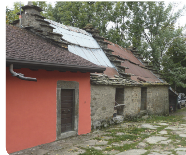
1. Casella . a dx capanna celtica con “penne” intermedie; a sx edificio pesantemente ristrutturato, la cui storicità può essere desunta dall’architrave della porta.
